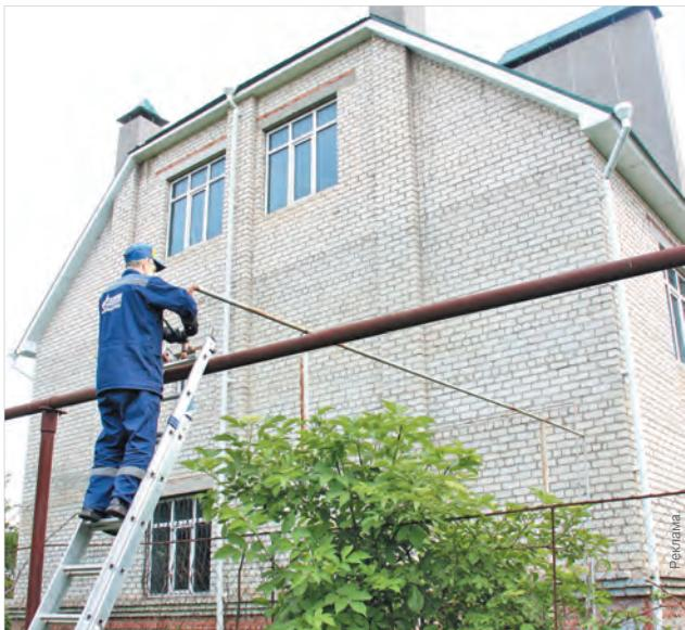
Прекращение поставки газа путем обрезки газопровода-ввода.
