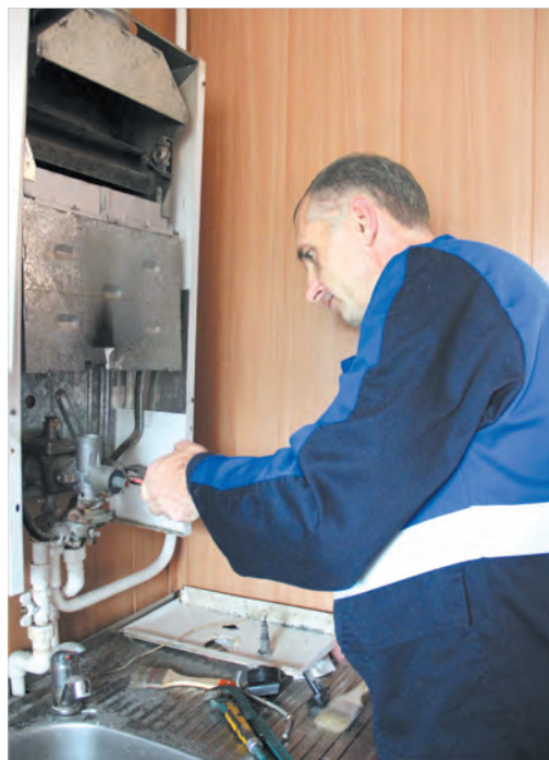
Проведение технического обслуживания внутридомового газового оборудования.
