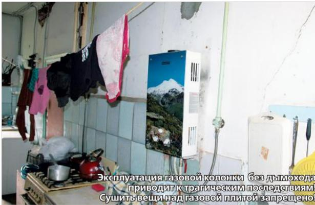
Эксплуатация газовой колонки без дымохода приводит к трагическим последствиям! Сушить вещи над газовой плитой запрещено!
