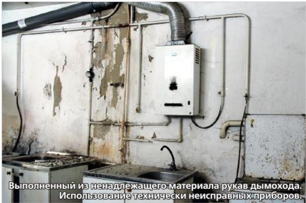
Выполненный из ненадлежащего материала рукав дымохода. Использование технически неисправных приборов.
