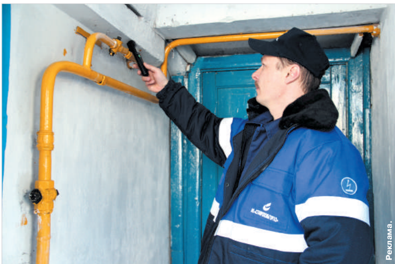
Проверка общедомовых газораспределительных сетей.
