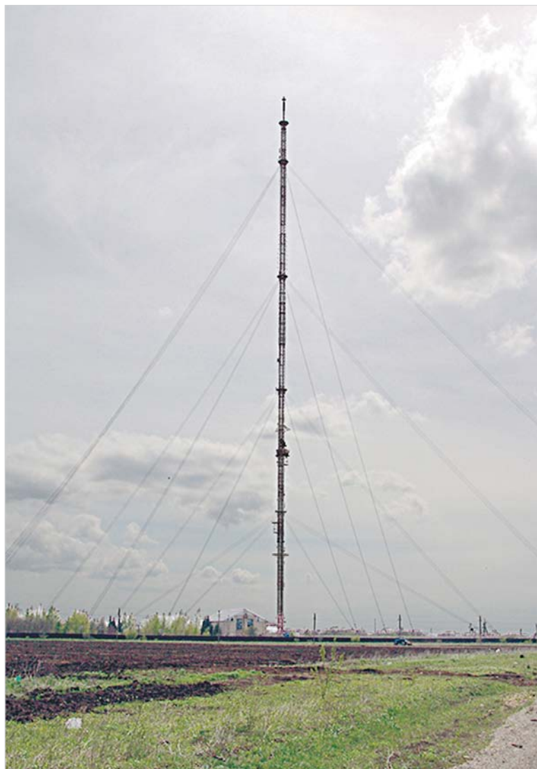
Вышка в Ставрополе высотой 350 м – самый высокий объект ЦЭТВ в крае.
