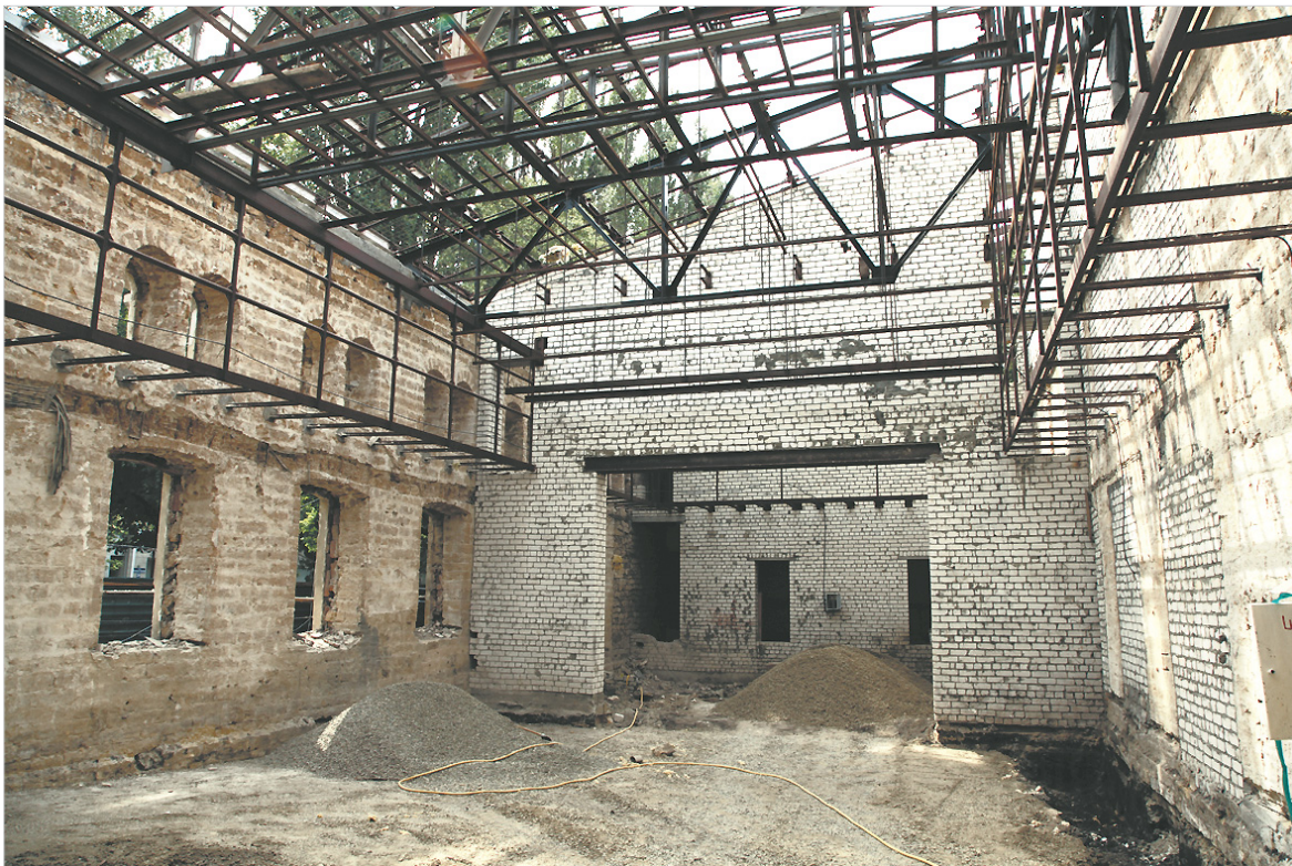
В здании театра идут реставрационные работы (фото предоставлено Ставропольским краевым театром кукол).
