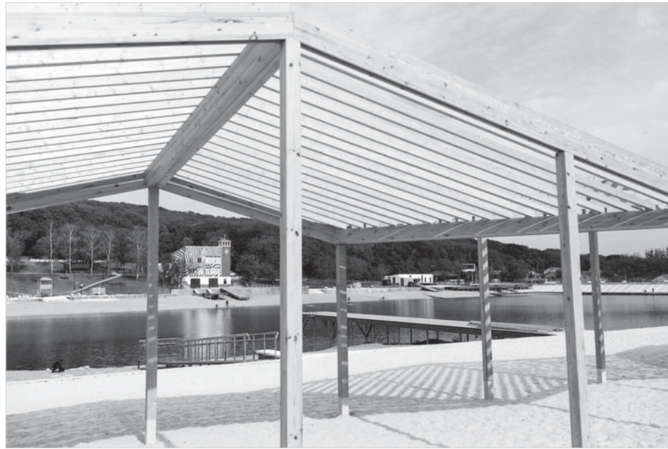
Территория Комсомольского озера после реконструкции.
