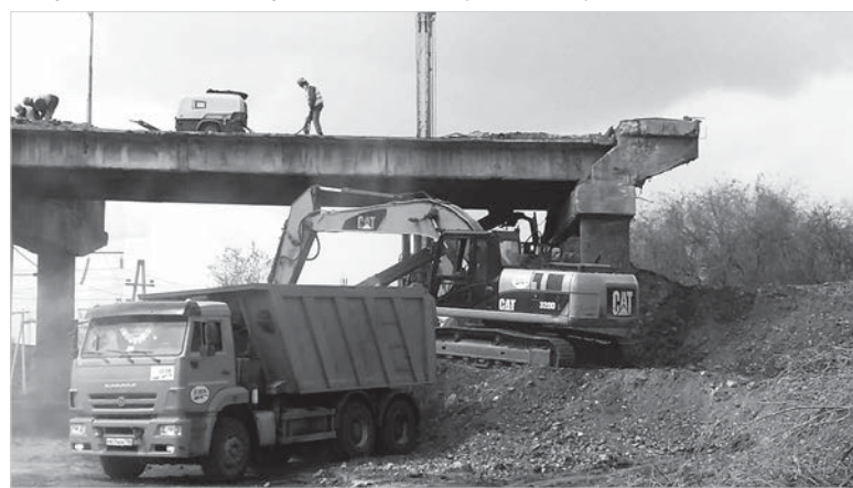
Ремонт путепровода в Невинномысске.
