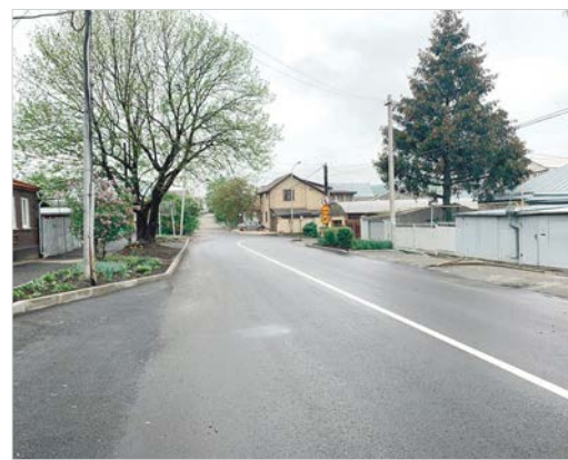
Отремонтированная улица Победы в Ставрополе.
