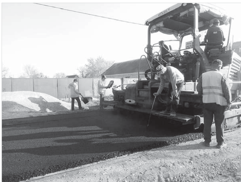
Ремонтные работы в крае идут с опережением графика.
