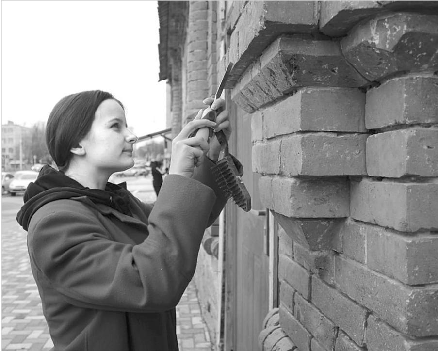
докомпоновали разрушенную местами кирпичную кладку. С цоколя дома убрали бетон, с оконных рам – краску. Кроме того, активисты перевесили три спутниковые антенны и развели проводку по фасаду.
