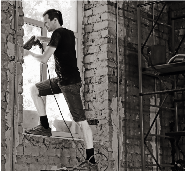
Идет капитальный ремонт школы
